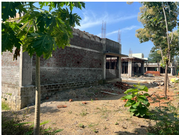
La construction du rez-de-chaussée de l'école est achevée
