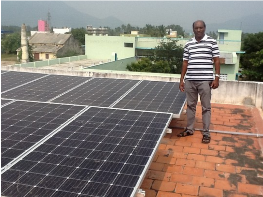
Lourdusamy lors de l'installation des panneaux solaires
