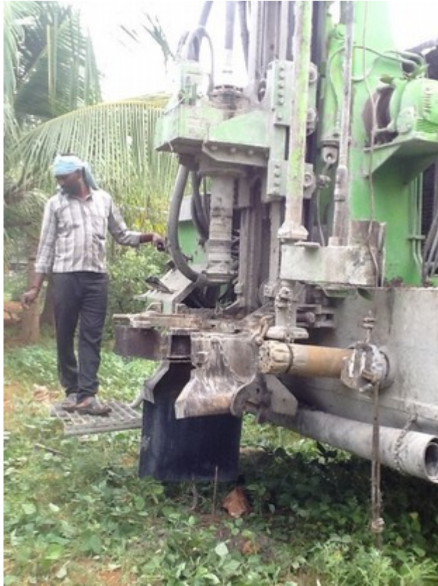
forage du puits à Shanti Lumine
