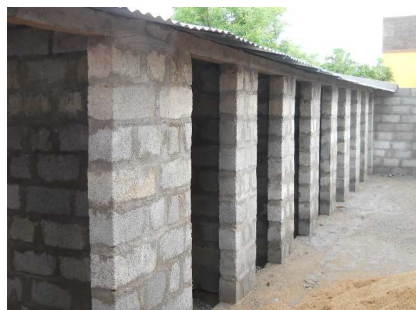
Construction des sanitaires
