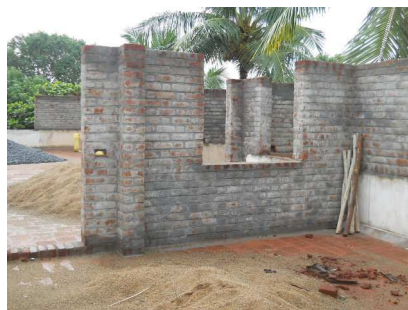
Construction du dortoir
